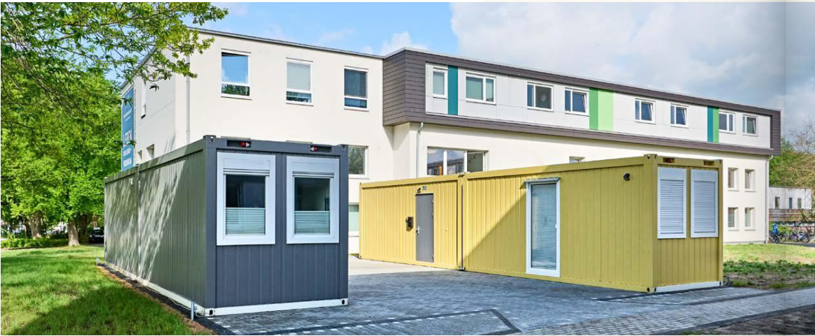
Das Areal um das Edo-Osterloh-Haus ist ein Mikrokosmos mit eigener Infrastruktur
